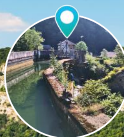
Notre centrale hydroélectrique à Chaley
